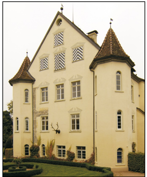
Foto 10: nach der Trockenlegung und anschließender Sanierung
